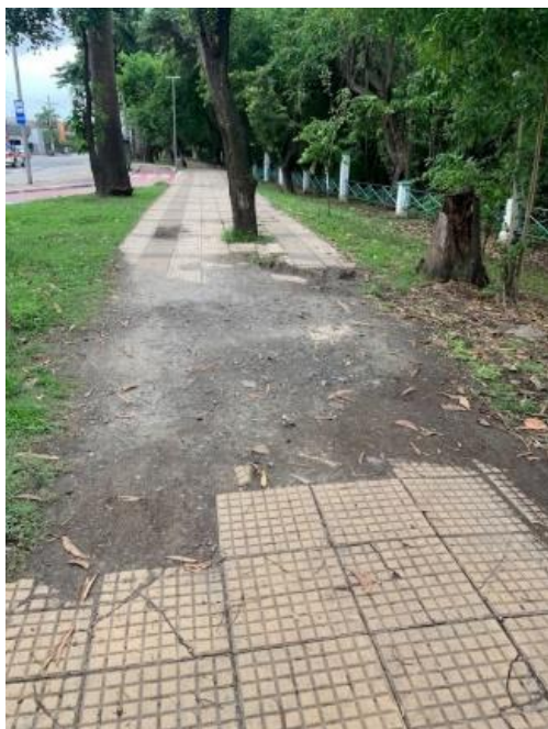
Trecho 01 – Falta de manutenção e piso inadequado sobre o aspecto de permeabilidade (Beira- Rio Trecho 01)
